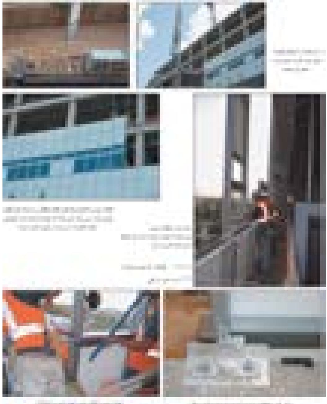
شکل ۸-۱۳ - مراحل نصب دیوار پرده ای یکپارچه
