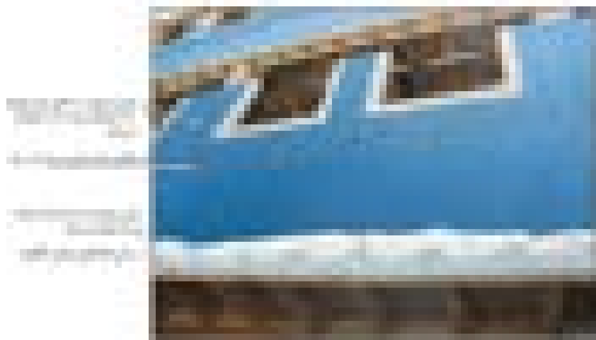
شکل ۵-۲۹- استفاده از ماده مخصوص کاهش‌دهنده خرابی در برابر آب و هوا قبل از اجرای نمای آجری
