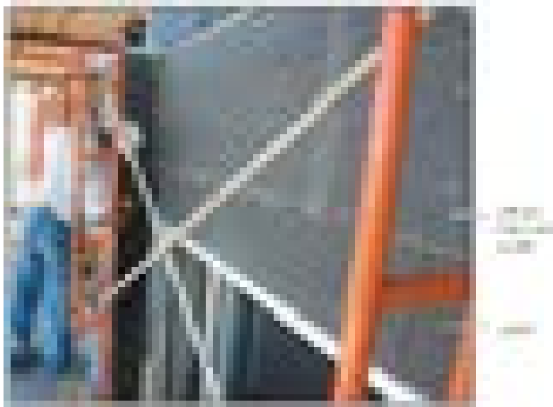
شکل ۶-۲- نصب توری فلزی خاردار (الگوی الماسی) بر روی قیرگونی
