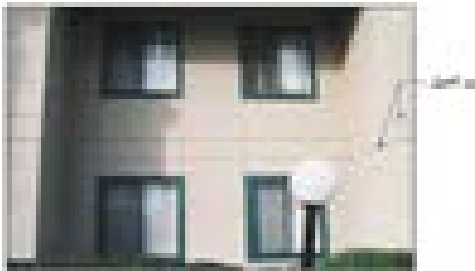
شکل ۶-۸- نمونه درزهای کنترل بر روی نمای سیمانی
