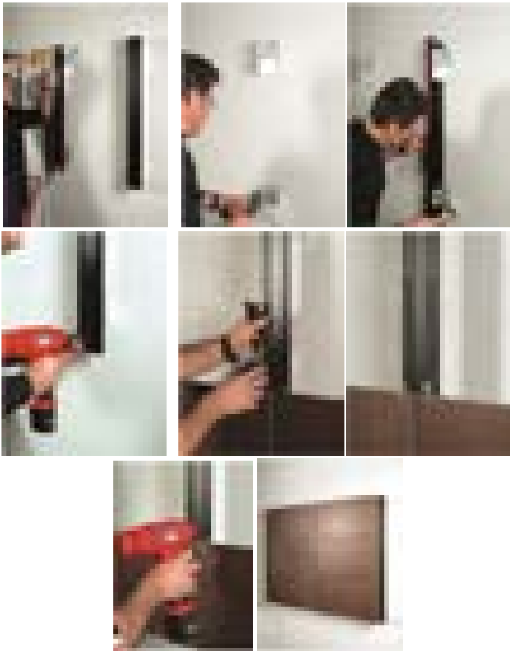
شکل ۷-۲۴- مراحل نصب سیستم نصب نمایان
