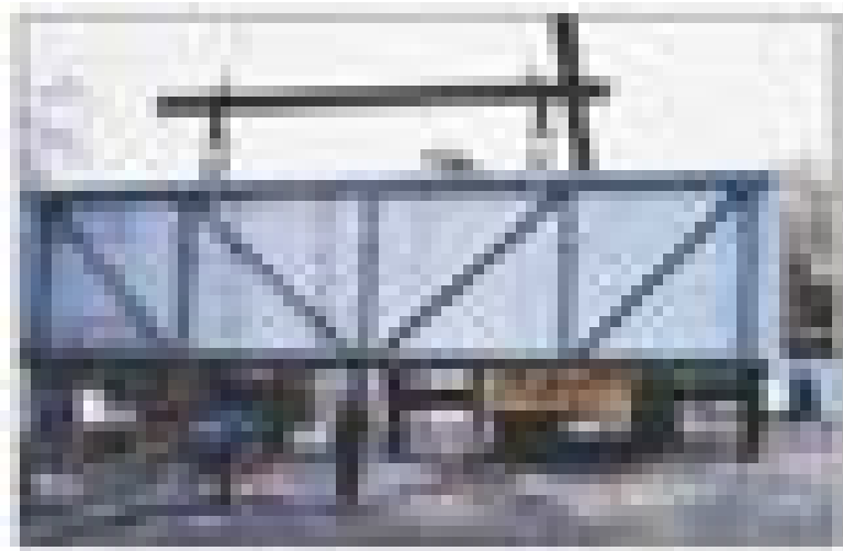
شکل ۴-۲۵- پانل دیواری پرده‌ای پیش‌ساخته سنگی
