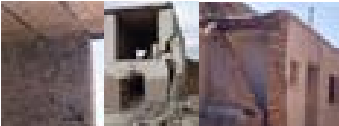
جداشدن دیوارهای متقاطع
